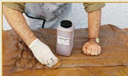
Die erste Grundierung wird von Hand in die Oberfläche eingerieben. Die weiteren Schichten...
